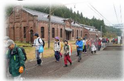
重厚感漂う旧丸山変電所
