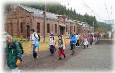
重厚感漂う旧丸山変電所
